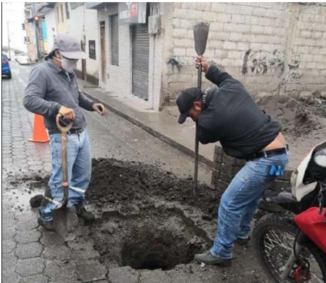
Ilustración 25. Trabajos en la Red de alcantarillado del de la ciudad de Pimampiro.
