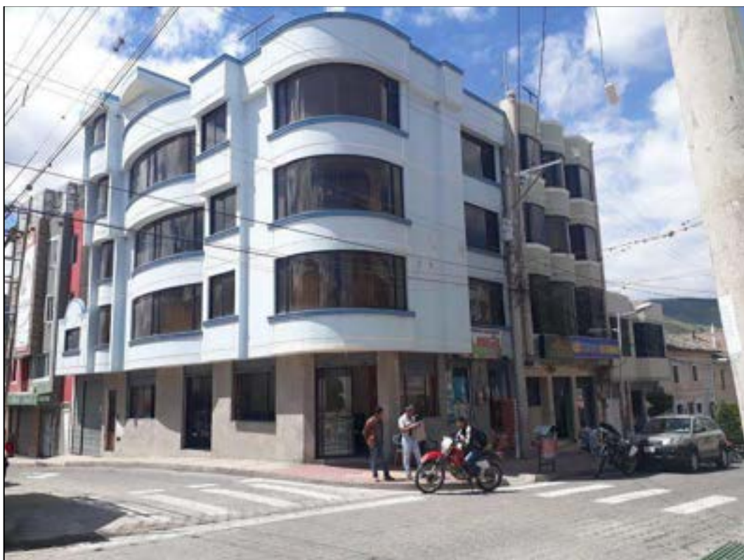
Fotografía 13. Edificación de 4 Pisos ubicada en la calle Bolívar
